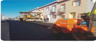
Imágenes realizando los trabajos
